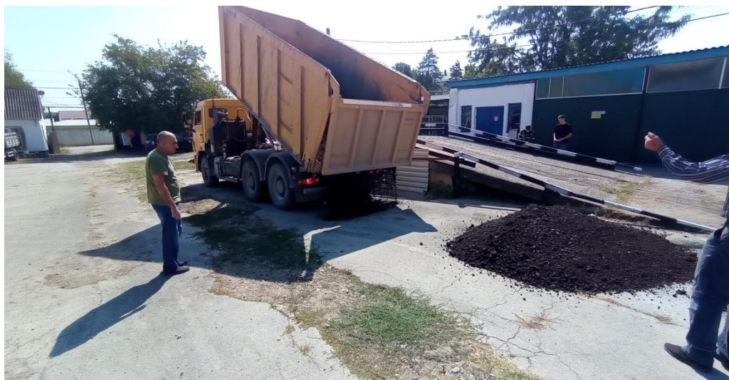
Рисунок 3. Завоз и укладка асфальтовой крошки
