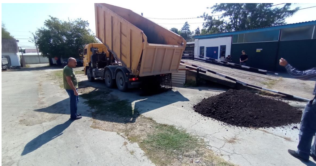
Рисунок 3. Завоз и укладка асфальтовой крошки
